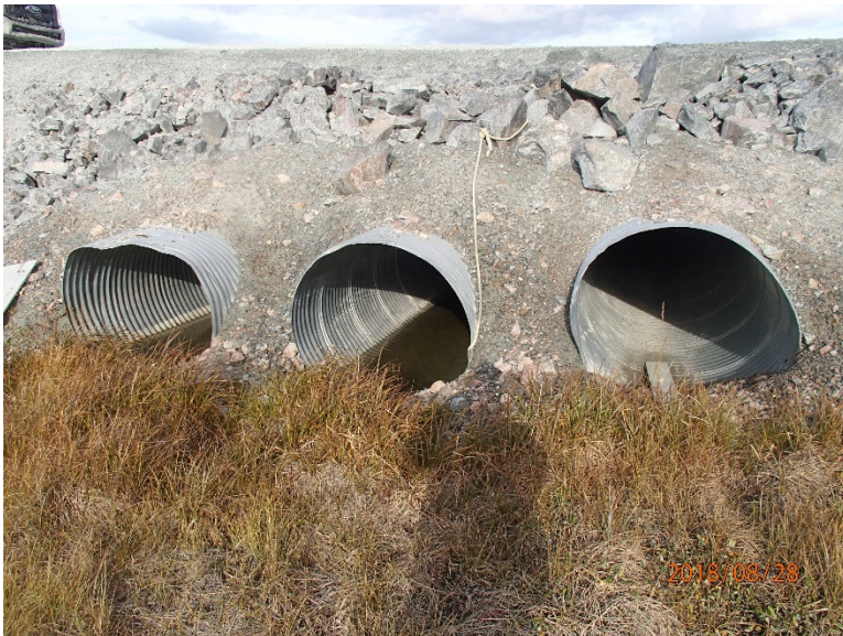
Photograph D1-26: R-26 km 104+400
