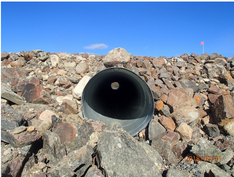
Photograph E1-2: Culvert #73 km 18+850
