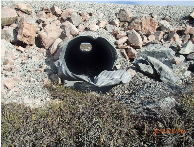
Photograph D1-19: R-20 km 85+490
