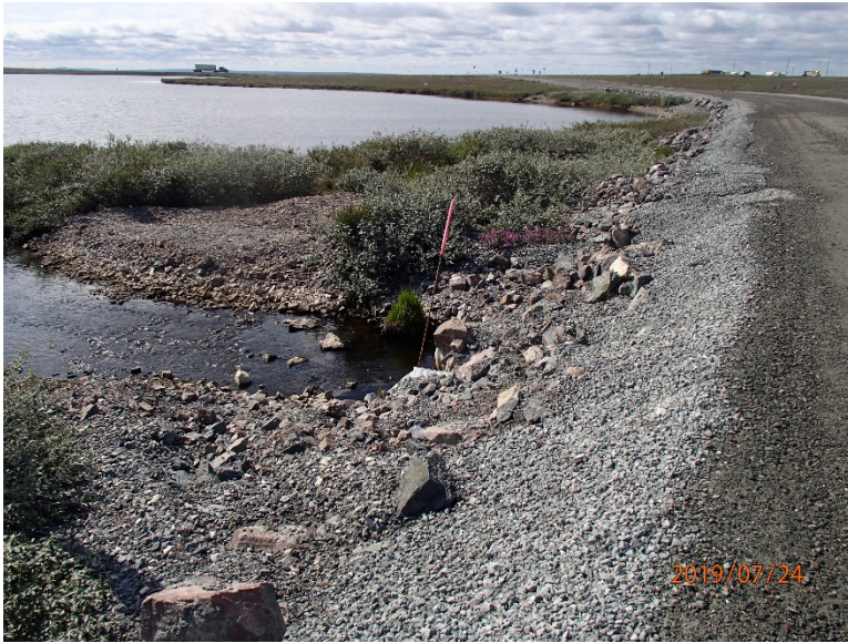
Photograph D2-1: PRC2 km 0+470
