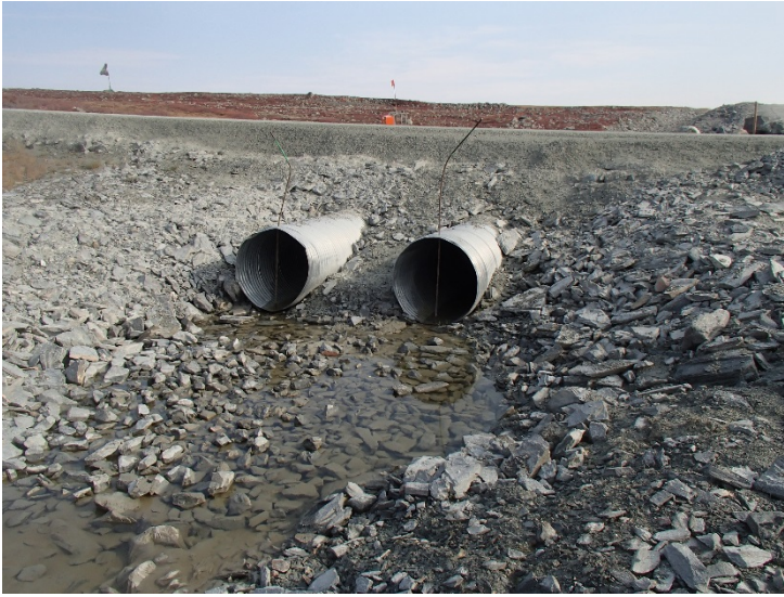
Photograph D1-73: R-26 km 104+400
