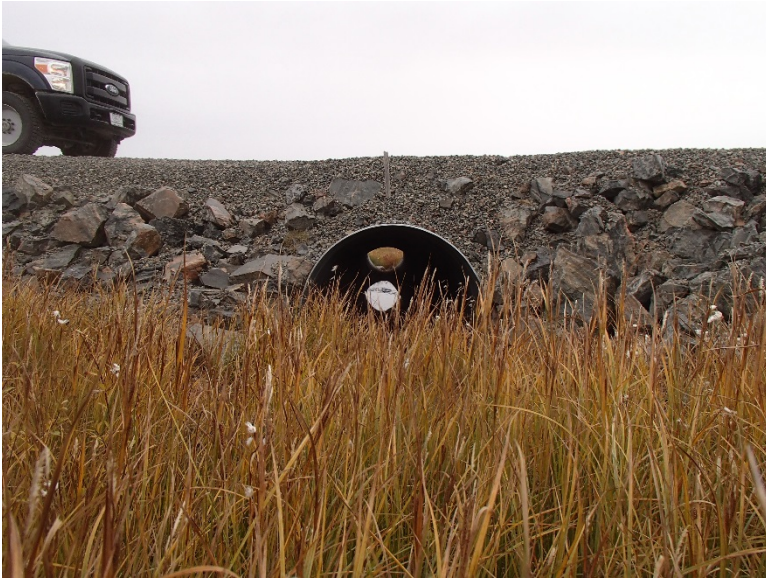
Photograph D1-19: R-04 km 12+050
