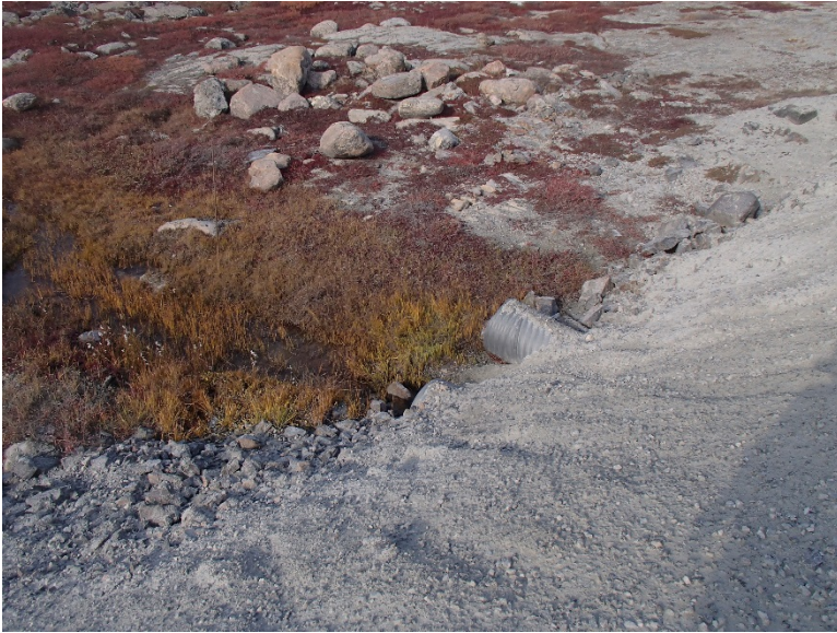
Photograph D1-71: R-25 km 101+950
