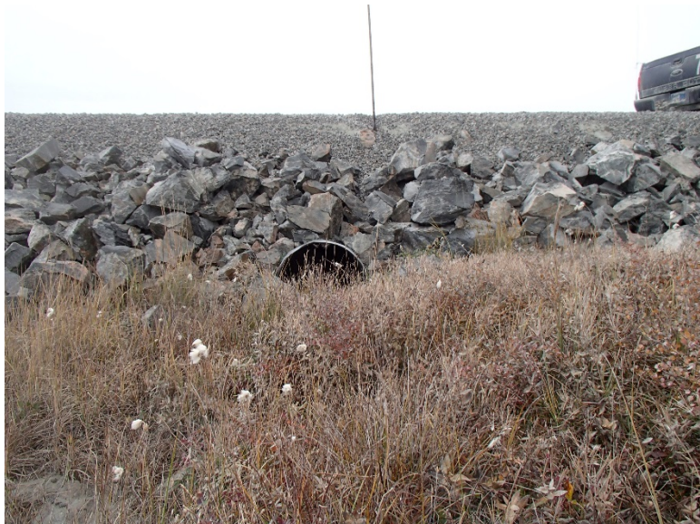
Photograph D1-23: PC-2 km 13+405
