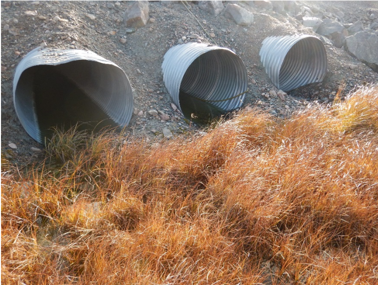
Photograph D1-73: R-26 km 104+400
