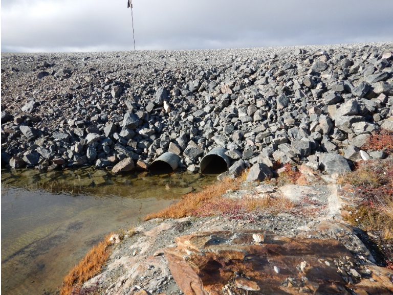
Photograph D1-71: R-25 km 101+950
