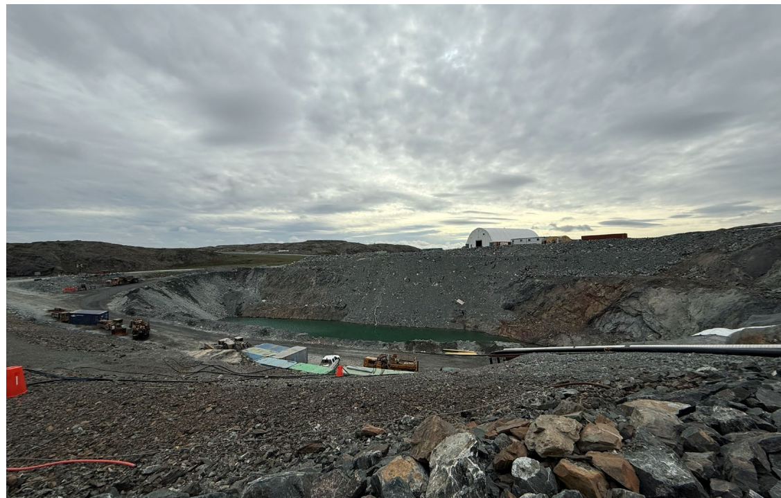
Photo 35: Naartok East pit inspection
